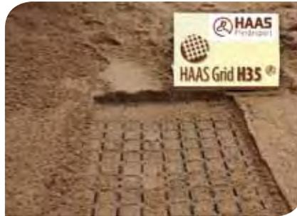
HAAS Grid H35 verfüllt, Sand als Tretschicht
