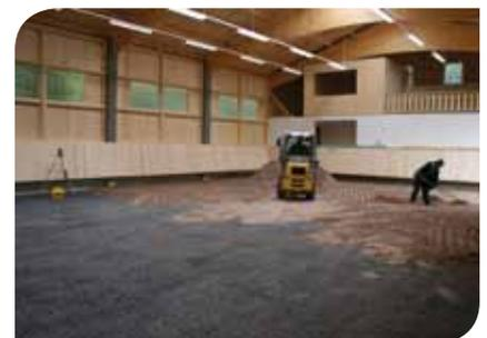
3) Reithalle mit Splittausgleich und Tretschicht
