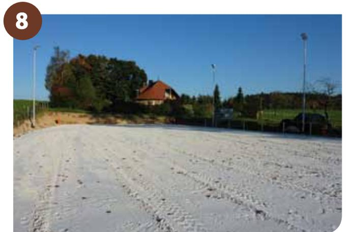
1. Auslauf / Reitplatz vor der Befestigung mit HAAS-Bodenraster. Vor Beginn der Arbeiten muss die Fläche ausreichend abgetrocknet sein.
